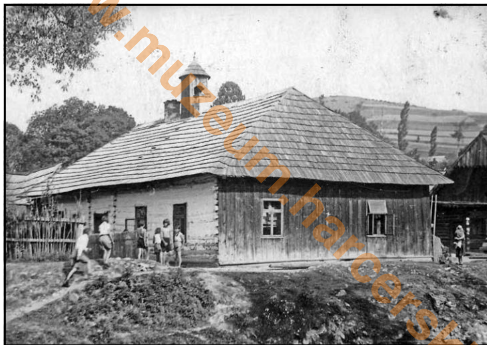
Budynek szkoły powszechnej w Jaworkach – miejsce zakwaterowania koloni harcerek, 1931 r., zbiory rodzinne Magdy Kraszewskiej
